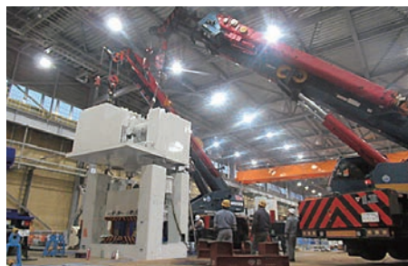
大型プレス機据付工事
